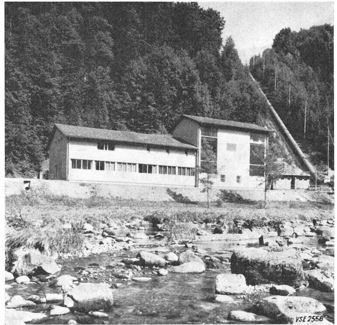
Fig. 2b Das neue Maschinenhaus Aufnahme 1967
