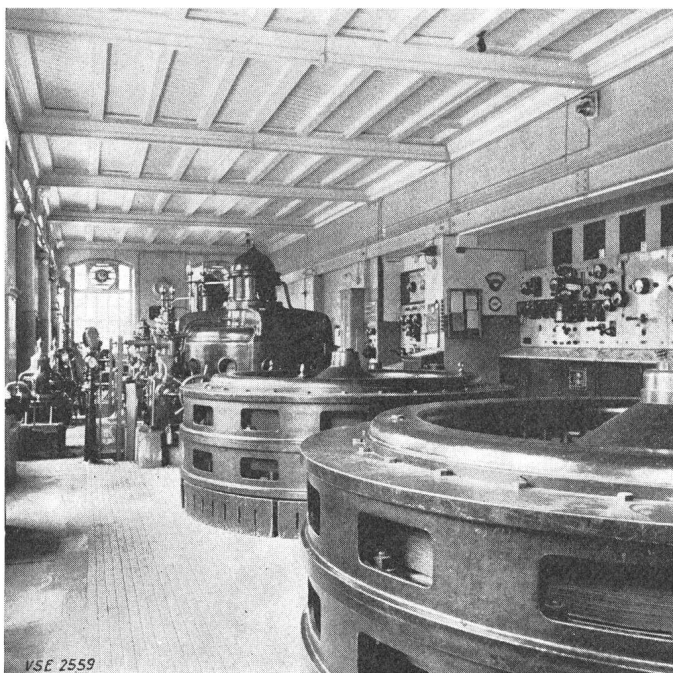
Fig. 3a Maschinensaal Aufnahme 1915
