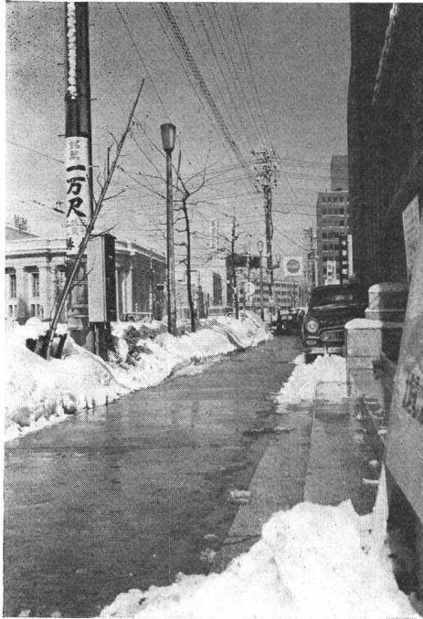
Fig. 4 Strassenheizung der Hokuriku Electric Power Co. in Toyama
