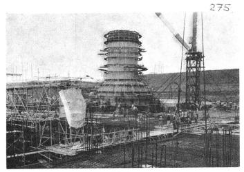
Fig. 2 Kernkraftwerk Fukushima der Tokyo Electric Power Co. mit  $1\times400~MW$  und  $1\times784~MW$  im Bau
