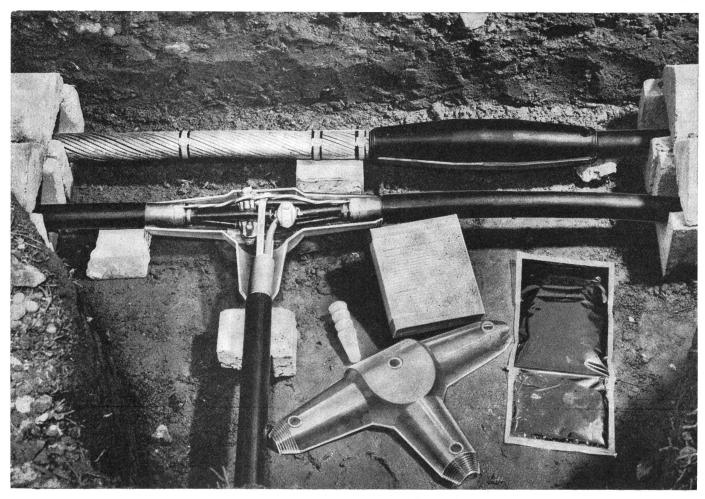
Giessharz-Kabelarmaturen zur Verbindung aller Kabeltypen:
