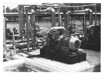
Fig. 2 **Pumpstation auf dem Raffinerieareal**Hier beginnt die Ölleitung nach Chavalon
