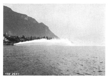
Fig. 16 Die Hochdruckentlastung in Tätigkeit Der Wasserstrahl kann eine Länge von 200 m erreichen
