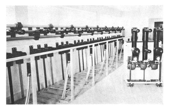
Fig. 2 Vollisolierte Schaltanlage ohne Stahlblechkapselung
