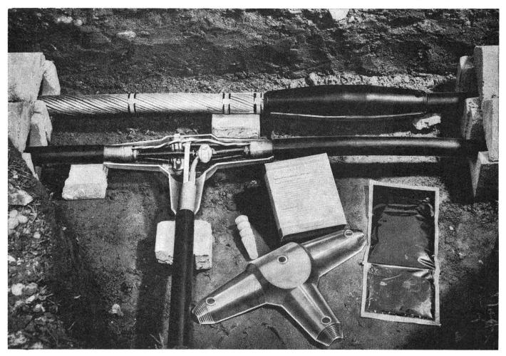
Giessharz-Kabelarmaturen zur Verbindung aller Kabeltypen:
