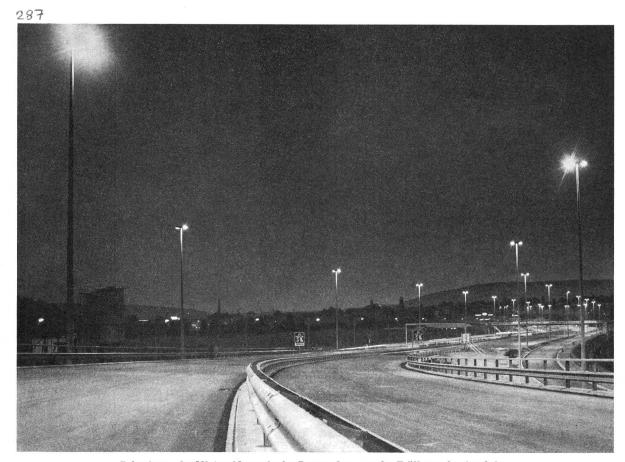
Beleuchtung des N3-Anschlusses in der Brunau, kurz vor der Eröffnung der Autobahn So zeigt sich dem Benützer der N3 in den Abendstunden die Einfahrt nach Zürich in der Brunau. Auffallend ist die gleichmässige, taghelle Ausleuchtung der unterschiedlich breiten Strassenstücke zwischen Brunau und Entlisberg
