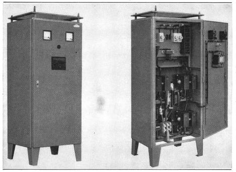
«stabilomat» Gleichrichter mit Thyristor-Gleichrichtersatz eignen sich sowohl für die Speisung von beliebigen Gleichstromverbrauchern, speziell als Ersatz für Akkumulatoren, wie auch für Batterieladung und Speisung von Notstromnetzen in Pufferschaltung Spannung und Strom können stufenlos eingestellt werden. Die Restwelligkeit der Ausgangsspannung ist sehr klein.
