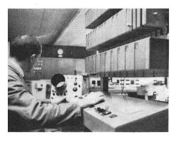
Nun – diese Steuerung enthält 15 000 Halbleiter und ist seit 22 000 Stunden in Betrieb, die andere mit 20 000 Halbleitern seit über 15 000 Stunden. Das sind insgesamt 630 Millionen Halbleiter-Betriebsstunden. Ohne Ausfall!
