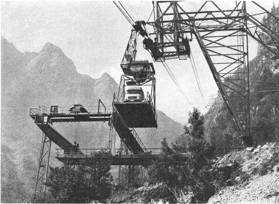
Fig.8 Transport des Messwagens mit der Luftseilbahn zur Zentrale Robiei (Maggia-Kraftwerk)
