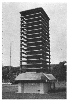
Fig. 2 Freiluft-Stossgenerator 2,4 MV, 50 kWs Baujahr 1958
