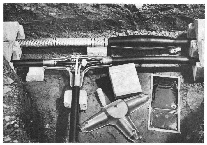
Giessharz-Kabelarmaturen zur Verbindung aller Kabeltypen:
