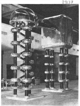
Gegenwärtig arbeitet Haefely gleichzeitig an drei Injektorspeisungen für Kernforschungszentren. Die technischen Daten der drei Gleichrichteranlagen unterscheiden sich nur geringfügig. Die maximale Betriebsspannung beträgt jeweils 850 kV, die Nennbelastung im statischen Betrieb 12 mA. Die Welligkeit der Beschleunigungsspannung und die Langzeitstabilität sollen bei Nennlast unterhalb 300 V zwischen den Scheiteln gemessen bzw. 75 V/h liegen.
