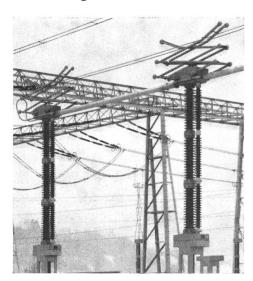
Wir verwenden Druckölantriebe mit hoher Kraftreserve. Dies hat sich bei vereisten Trennern als besonders günstig erwiesen. Die Stromübertragung erfolgt litzenfrei über gekapselte Druckkontakte. Der Übergangswiderstand der Strombahn ändert sich auch bei jahrelangem Betrieb höchstens unbedeutend. Ein angebauter Erdtrenner mit 100%iger Kurzschlussfestigkeit ermöglicht eine sichere Erdung.
