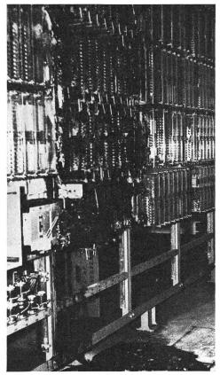
Fig. 1 Brand in einer Telephonzentrale (BLS-Bahn, Spiez)
