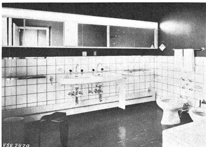
Direktheizung im Badezimmer
