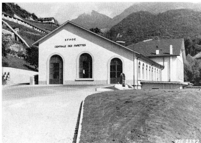
hält nun zwei Maschinengruppen von je 10 000 PS. Die eine der beiden Gruppen dient als Reserve und würde außerdem nach Umbau der wasserbaulichen Anlagen die Erzeugung vermehrter Sommerenergie erlauben, falls sich die Marktlage für solche Energie später wieder einmal ändern sollte.
