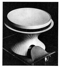
Gebäude ist ein Rotationshyperboloid, dessen runde Ausstellungsfläche in 9 m Höhe liegt. Diese kann durch einen Schnellift erreicht werden.
