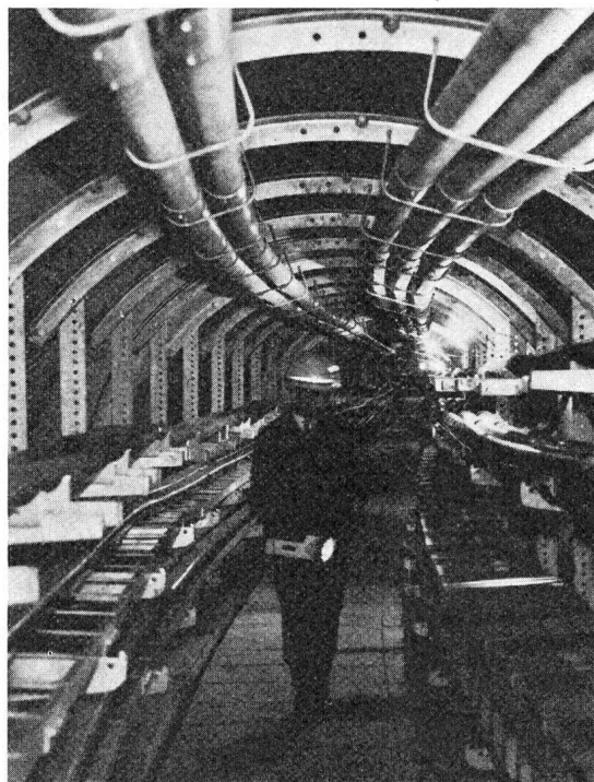
Fig. 26 1,3 km langer Kabeltunnel im Yaesu-Netzbezirk
