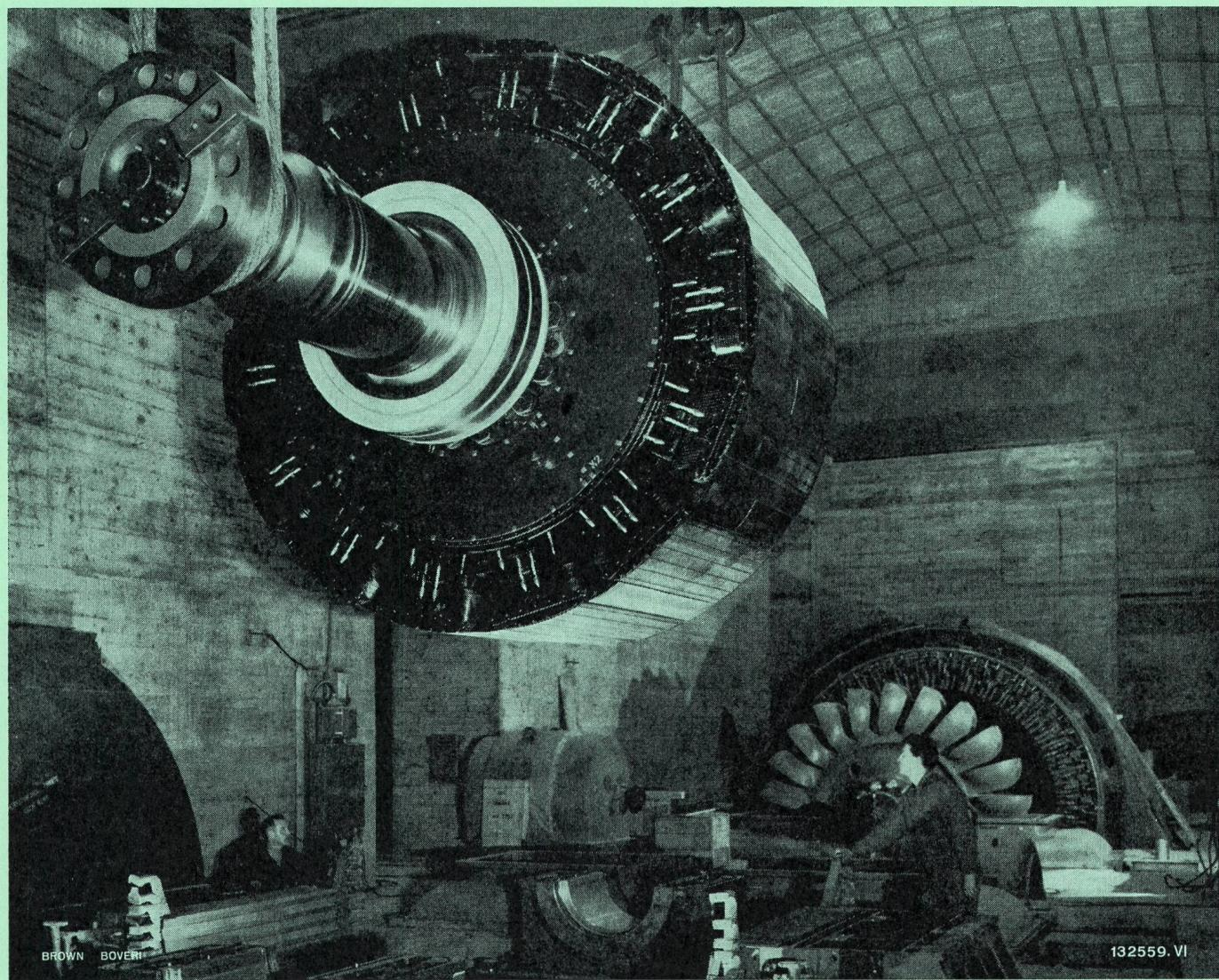
Brown Boveri baute erstmals in der Welt zwei horizontale Wasserkraftgeneratoren mit direkter Wasserkühlung im Stator und Rotor. Diese Maschinen mit einer Nennleistung von je 86 MVA sind in der Zentrale Bavona der Maggia Kraftwerke AG, Locarno, installiert.
