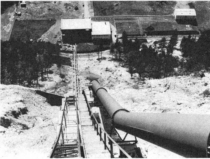
Fig. 7 Das Diessbachwerk mit vorerst einer Druckrohrleitung
