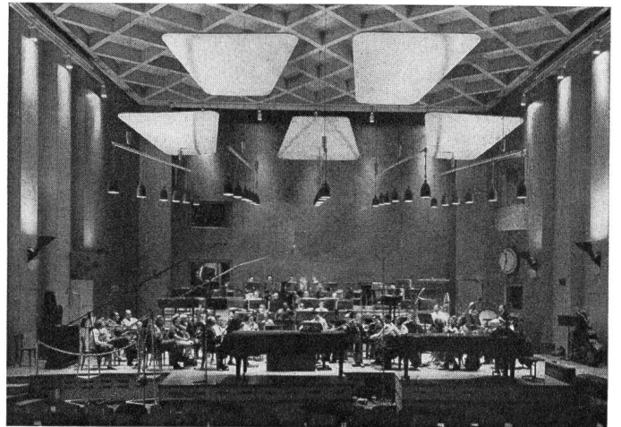
Fig. 4 Le grand studio de Zurich Equipé de 5 réflecteurs en fibres de verre agglomérées
