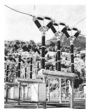
Fig. 1 **Hochspannungs-Hochleistungsschalter** Typ FS 12c3, für 2 kA, 12 500 MVA bei 220 V, in der Schaltanlage Britsch
