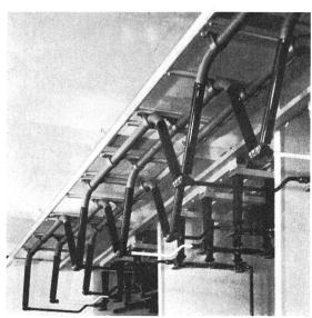
Fig. 1 **Hochspannungsanlage**Vollisolierte Sammelschienen «Duresca» für 72,5 kV;  $U_{\rm p}=140~{\rm kV};~ \hat{U}_{\rm h}=325~{\rm kV}$
