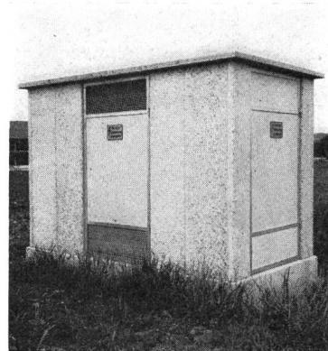
Fig. 1 Vorfabrizierte Transformator-Station in Kunststein
