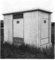
Fig. 1 Vorfabrizierte Transformator-Station in Kunststein
