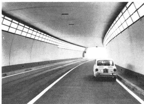
leuchtung. Die Beleuchtung in der Adaptationsstrecke wird in Abhängigkeit von der Aussenhelligkeit automatisch gesteuert.
