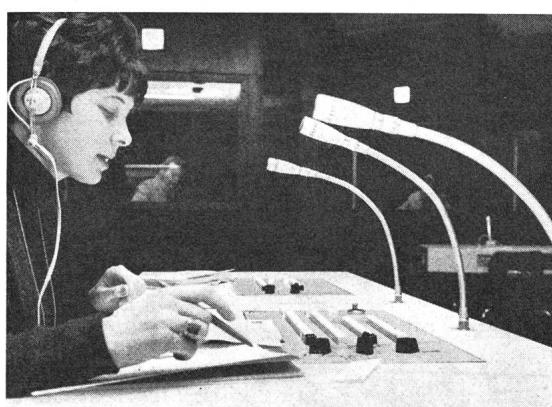
metsch-Übungsanlage. Unser Bild zeigt einen Blick in einen der Übungsräume, in denen die Studenten im Simultan- und Konsekutivdolmetschen geschult werden. Im Vordergrund ein Dozentenplatz, von dem man sich z. B. über Kopfhörer und Mikrophon in jede Dolmetsch-Kabine (im Hintergrund) einschalten kann.
