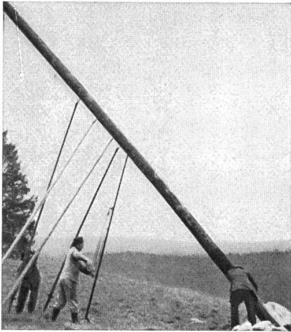
Leitungsbau im Kanton Bern mit LIFTY Stangenwinde
