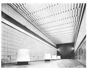
Der Maschinensaal der Pumpstation Zmutt Gruppen: 2×29,7 MW und 2×13,55 MW
