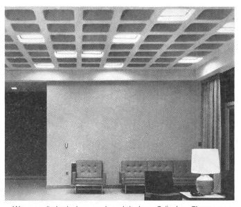
Wo aus ästhetischen und praktischen Gründen Fluoreszenzröhren weder erwünscht noch anwendbar sind, können Decken mit Quadraten oder Rechtecken aus Panel-F-Elementen hübsch gemustert werden. Hier sind sie in verschalte Kassetten aus Gussbeton eingelegt. Weil jede Lampe so viel Licht ausstrahlt wie eine 1,5 m lange Fluoreszenzröhre, ist dieser Empfangsraum in gleichmässiges, überall zum Lesen einladendes Licht getaucht.
