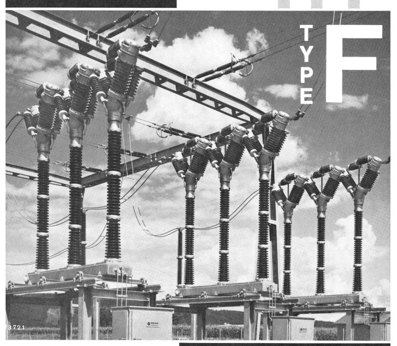
reipoliger Schalter Typ FS 12 r 3, 220 kV, 2000 A, 2 000 MVA, im Unterwerk Münchwilen der ordostschweizerischen Kraftwerke AG
