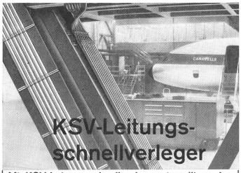
Mit KSV-Leitungsschnellverlegern installierte Anlagen sind übersichtlich, sauber und modern. Verschiedene Typen für Montage an Ankerschienen, Flach- und Schlitzbandeisen, Winkeleisen usw. Für Leitungsdurchmesser von 8 bis 120 mm.
