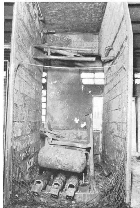
Fig. 5 Zerstörte Transformatorzelle 10 kV-Schalter
