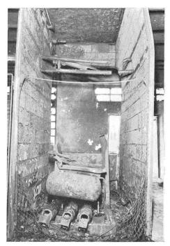
Fig. 5 **Zerstörte Transformatorzelle**10 kV-Schalter
