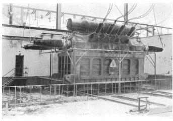
Fig. 2 **Der Wander-Transformator**  $U_7$  **vor der Störung**
