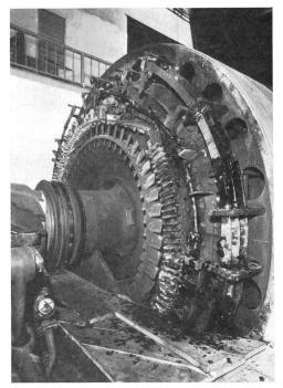
Fig. 4 **Der Generator**  $G_3$  **nach dem Brand**(Die Schutzhülle ist entfernt)
