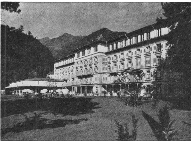
Grand Hotel «Quellenhof» Bad Ragaz. Hier heizt man angenehm und wirtschaftlich sämtliche Zimmer, Bäder, Hallen und Bäderkorridore mit Star Unity Elektro-Strahlungs-Heizung
