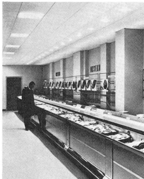
Cool-Beam-Lampen können – verglichen mit anderen Glühlampen gleicher Leistung – die Temperatur in offenen Tiefkühltruhen um 1½–3 °C senken.
