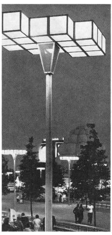
Diese Promenade besteht aus originell zusammengesetzten 30-cm-Lichtwürfeln. Jeder Kubus wird von einer einzigen Lampe voll ausgeleuchtet. Die kühn wirkenden, nur 3,8 cm breiten Fassungen sind möglich, weil die Würfel ein geringes Gewicht haben (960 g pro Element).
