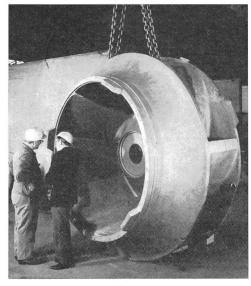
Fig. 2 Laufrad einer vertikalen Kühlwasserpumpe
