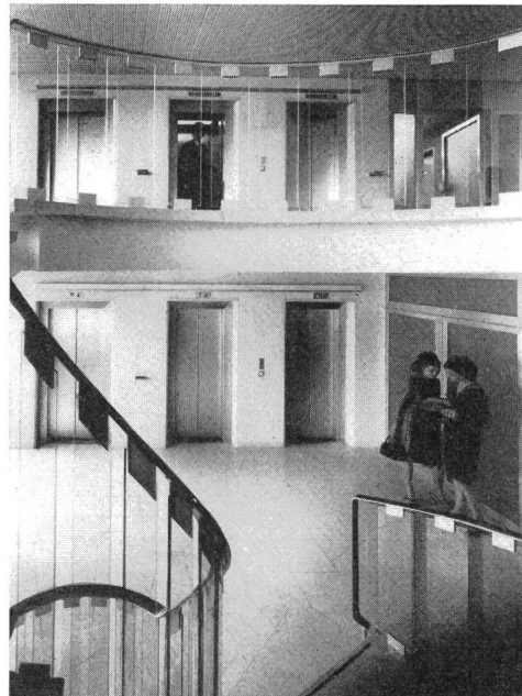
Fig. 1 Schindler-Aufzüge mit automatischen, zentralöffnenden Horizontal-Schacht- und Kabinenschiebetüren
