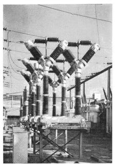
Fig. 1 Ölarmer Oerlikon-Hochleistungsschalter 2000 A, 8000 MVA bei 150 kV
