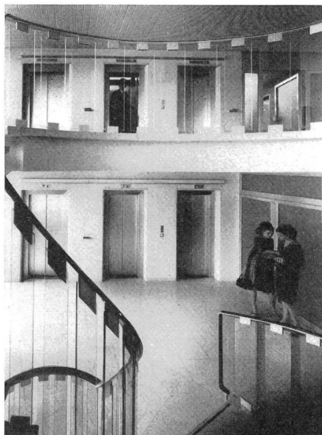
Fig. 1 Schindler-Aufzüge mit automatischen, zentralöffnenden Horizontal-Schacht- und Kabinenschiebetüren
