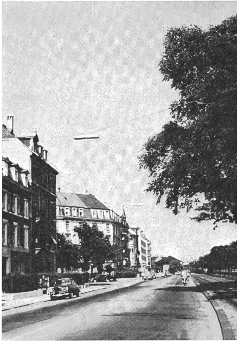
Fig. 1 Hauptstrasse mit Leuchten für 2 \times 250 (400) W HQL-Lampen
