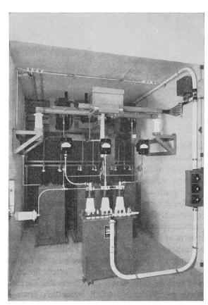
Kopplungszelle (Parallel-Einspeisung) (Photo ZAG)
