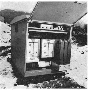
Fig. 2 Hochspannungs-Schaltschrank
