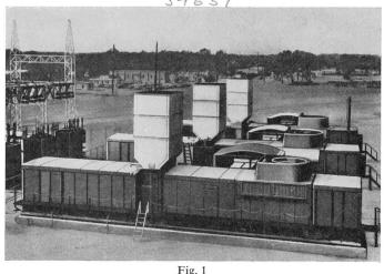
Drei Gasturbinen-Kraftwerke von je 14 MW in Package-Bauweise
