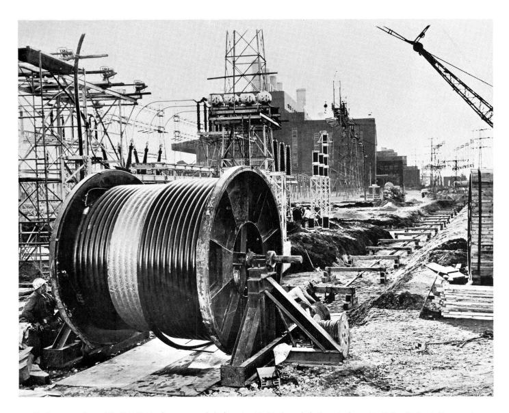
Verlegung eines 70 kV-PE-Hochspannungskabels als Verbindungskabel zwischen Freiluft- Unterstation und Industrie Hauptverteilung.
