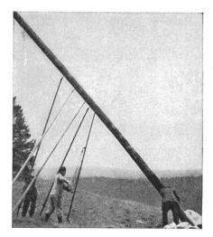
Leitungsbau im Kanton Bern mit LIFTY Stangenwinde
