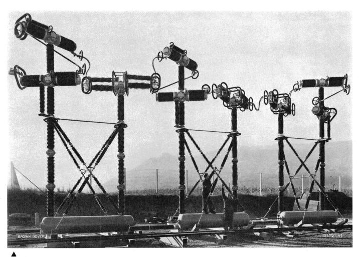
Pol eines 735-kV-Druckluftschalters, 60 000 MVA Ausschaltleistung, bestimmt für das Manicouagan-Projekt der Quebec Hydro-Electric Commission, Montreal, Kanada.
