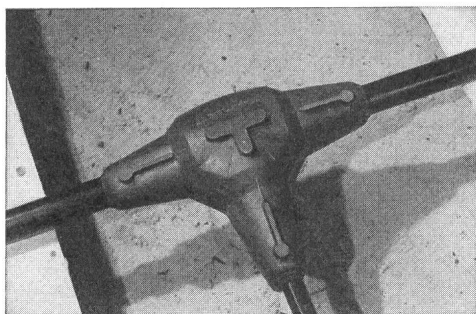
Montierte Hausanschlussmuffe
