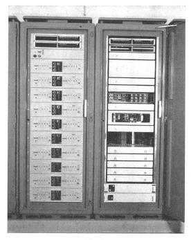
Fig. 3 Speicherschrank und Sendeeinrichtung im Unterwerk
