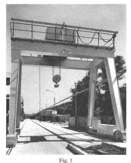
Portal-Kran in geschweisster Kastenkonstruktion
