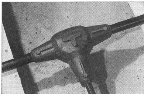
Montierte Hausanschlussmuffe
