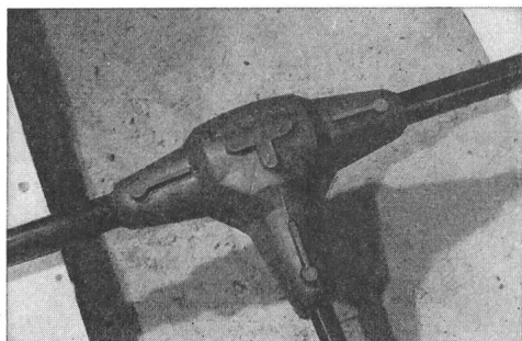
Montierte Hausanschlussmuffe
