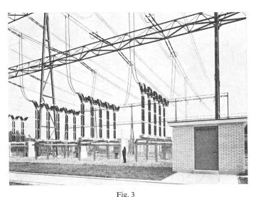
380-kV-Höchstspannungs-Ölstrahlschalter im Unterwerk Breite
