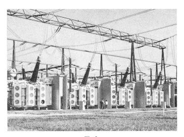
Fig. 2 380/220-kV-Transformatorengruppe im Unterwerk Breite Nennleistung 600 MVA Die vierte Einheit dient als Reserve
