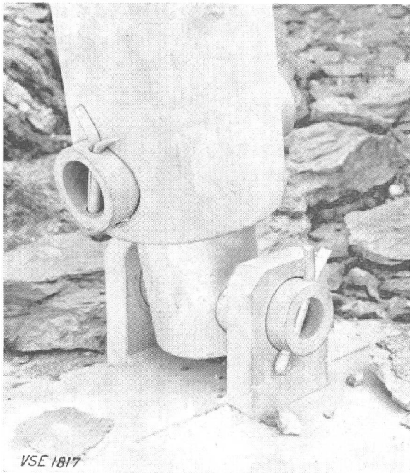
Fig. 3 Detail eines Kardangelenkes
