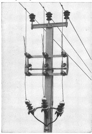
Sectionneur de dérivation 24 kV, 400 A
