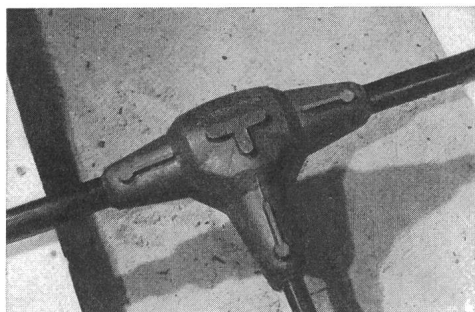
Montierte Hausanschlussmuffe
